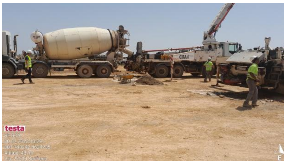
Hormigonado durante la visita a SCA.
